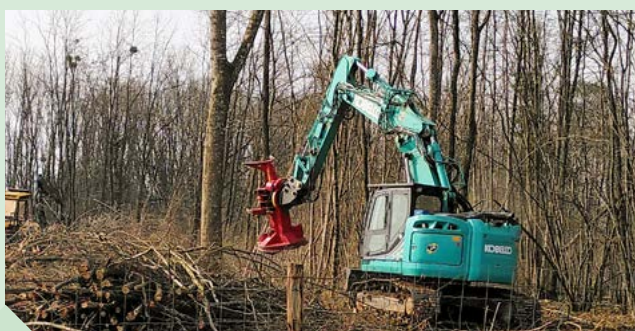
Pelle hydraulique de 24 tonnes, grue de portée 10 m
