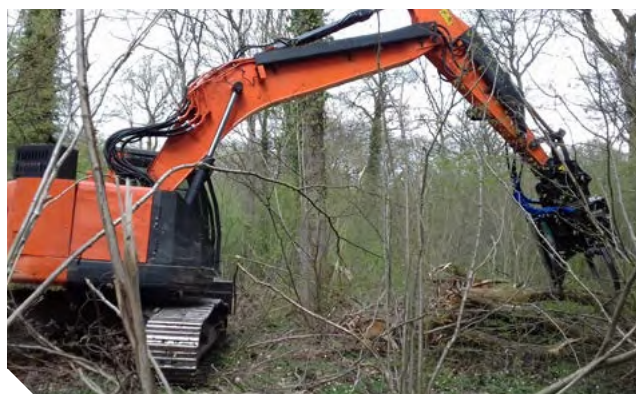
Pelle hydraulique de 24 tonnes avec une portée de 8 m
